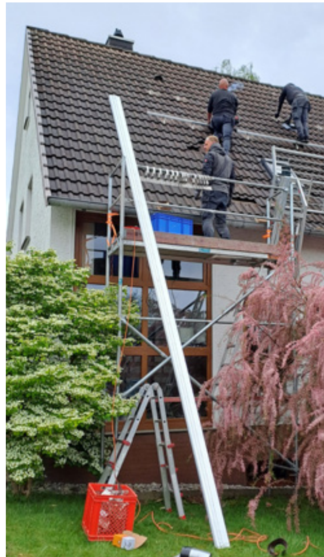
Es ist soweit: Die Module der Photovoltaikanlage werden installiert. Foto: Patt
